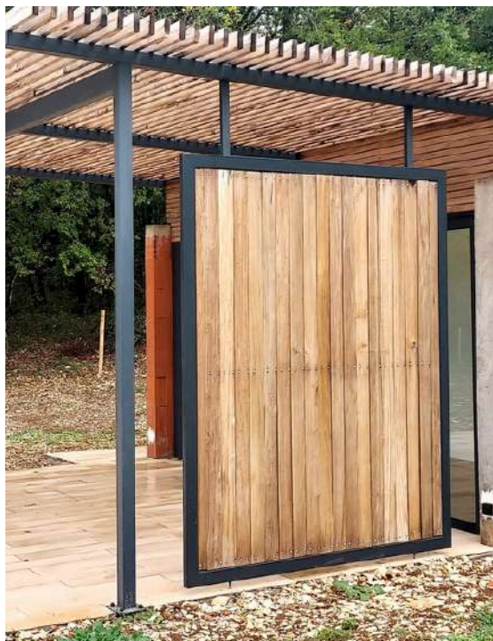
Vue extérieures : lames fermés
